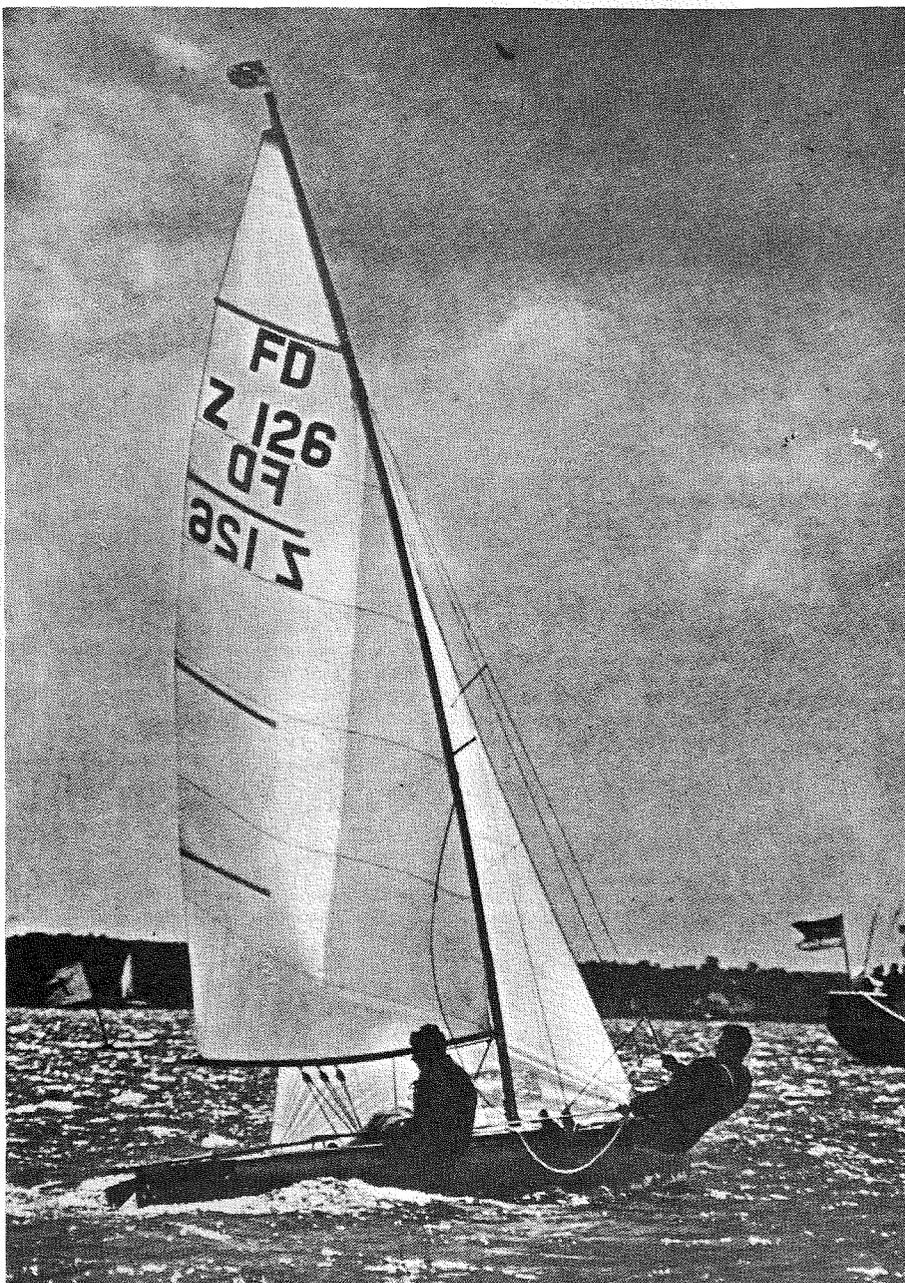
*Un Flying Dutchman ciñendo. Obsérvese la posición cerrada de las velas, el pequeño valor del ángulo beta (representado por la botavara, soporte inferior de la vela), la posición del tripulante en el trapecio y la diferencia de orientación del grimpolón y las banderas.*
