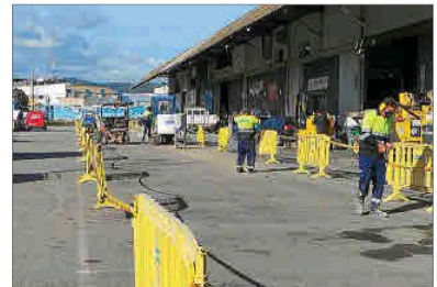
Los operarios han empezado a habilitar el espacio.
